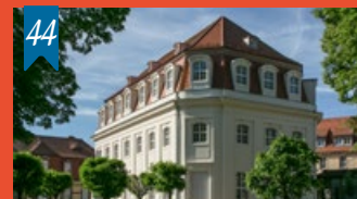
Bad Lauchstädt Kursaal
